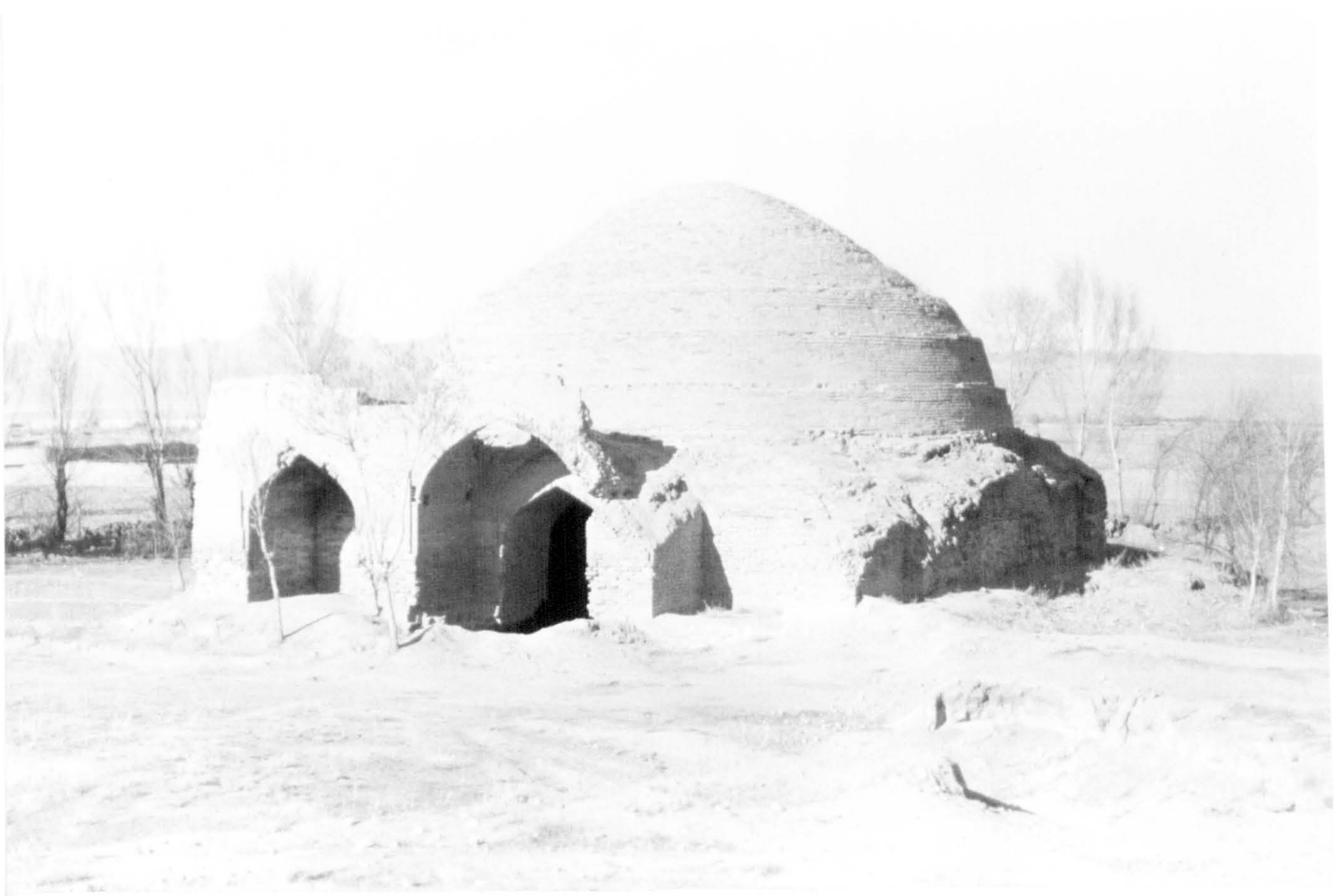
244) Langar: cistern, exterior, general view
