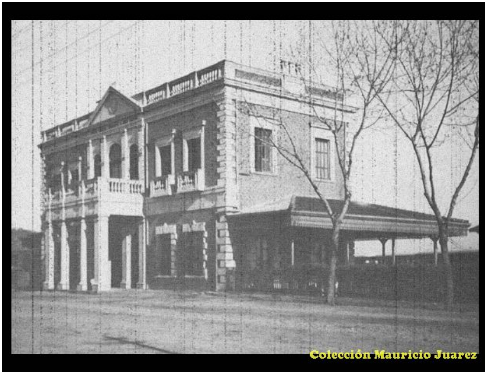
Figure 3–114. First Alta Cordoba Station. Source: Mauricio Juárez, ‘Estación Alta Córdoba Norte y Desvío particular YPF’, http://www.trencordobes.com.ar/?cat=15&paged=2 (accessed September 14, 2017).
