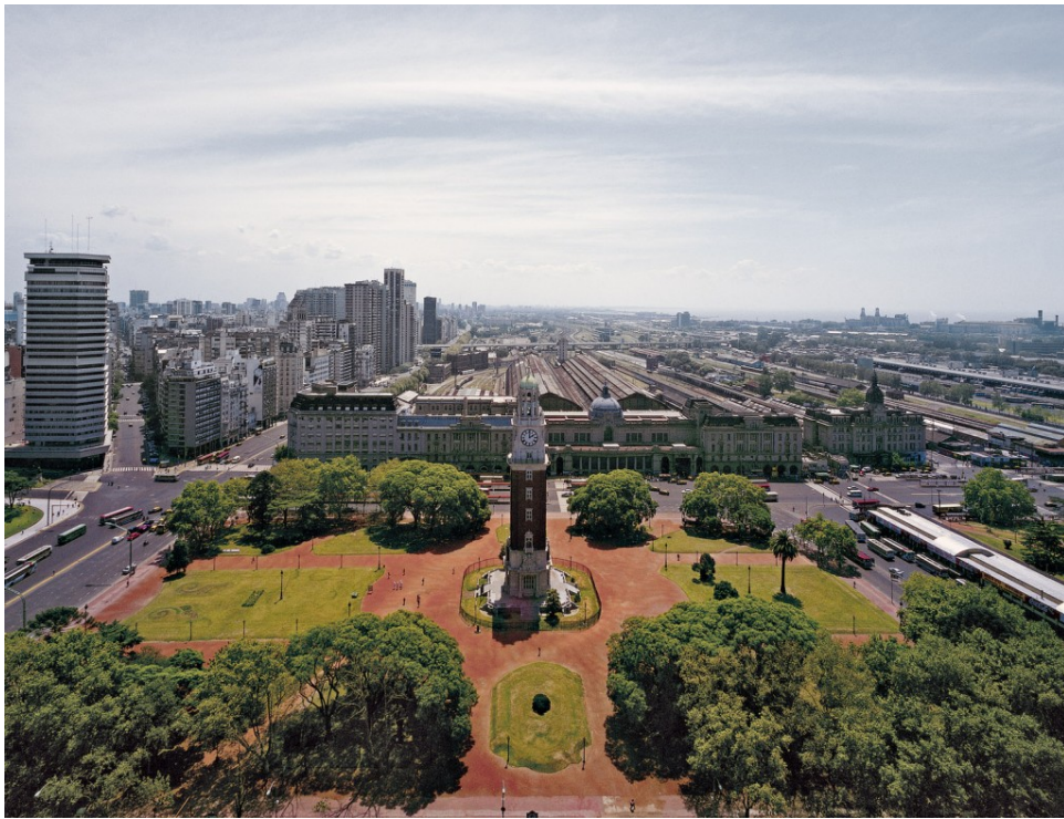
Figure 3–9. View of Britannia Square and Retiro Stations. Source: J.P. Pekarek, ‘Conjunto Monumental Ferroviario de Retiro’, http://monumentos.cultura.gob.ar/inventario/conjunto-monumental-ferroviario-de-retiro/ (accessed September 1, 2017).
