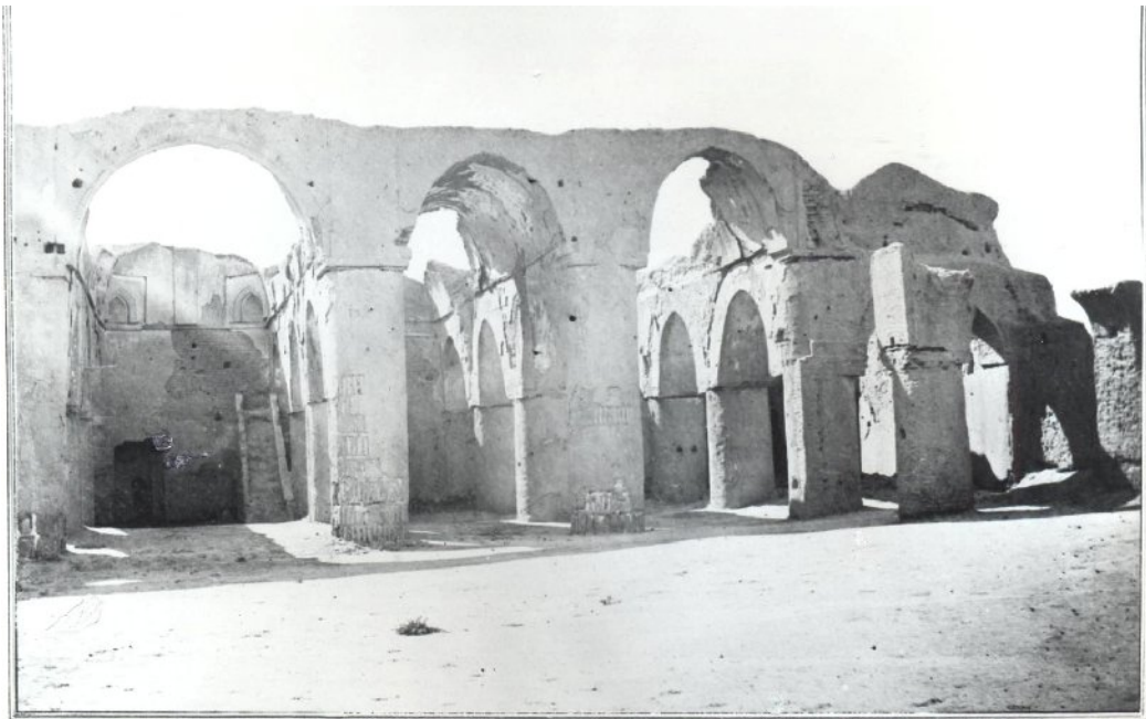
Pl.1.6. Tārī Khānā. View of the main aisle, 1312/1894.
