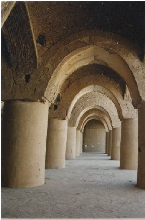
Pl.1.4. Tārī Khānā. Elliptical arch.
